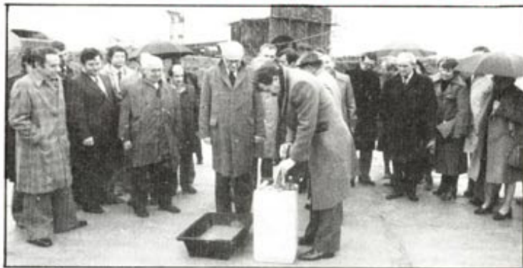
Pose de la première pierre
