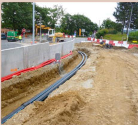
Tranchées permettant d'enfouir des tubes du réseau sous la voie.
